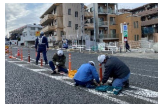
<道路の施設修繕>
