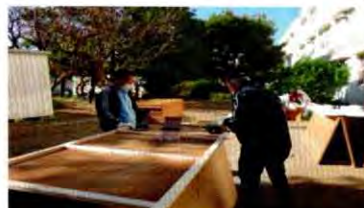
枠組みの組み付け
