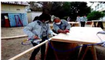
合板の張り付け
