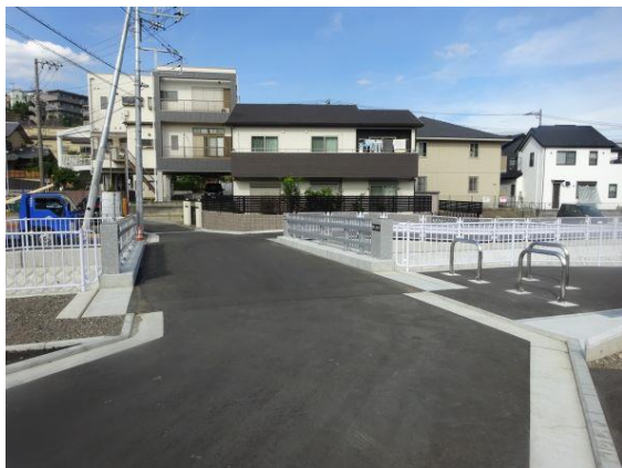
完成した橋際橋
