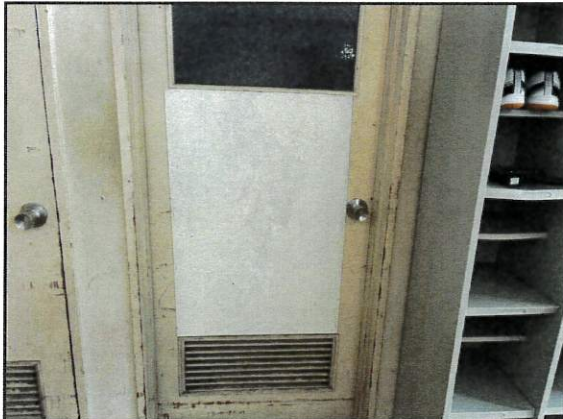
格技室更衣室ドア補修
