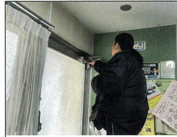
印刷室ドア修理
