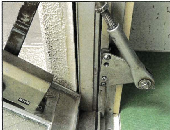
印刷室ドア修理
