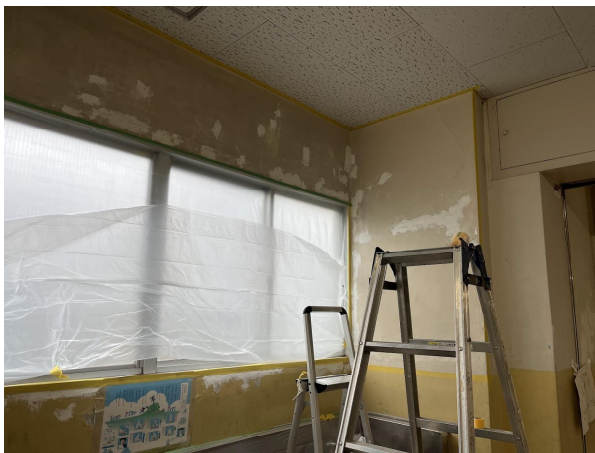
29 日 補修仕上げ
