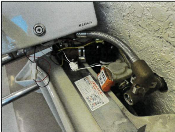
小便器の電池交換
