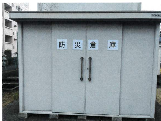
貯水塔裏側の倉庫
