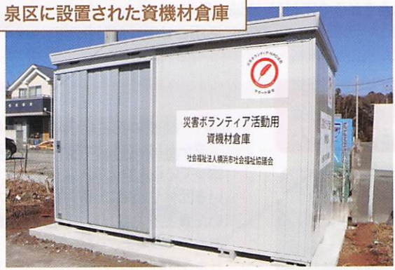
泉区に設置された資機材倉庫
