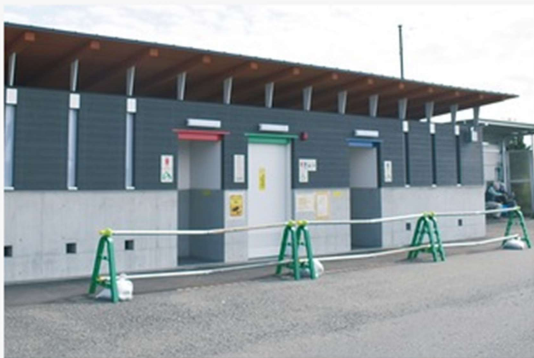
かまくらみち浴いに設置されている
