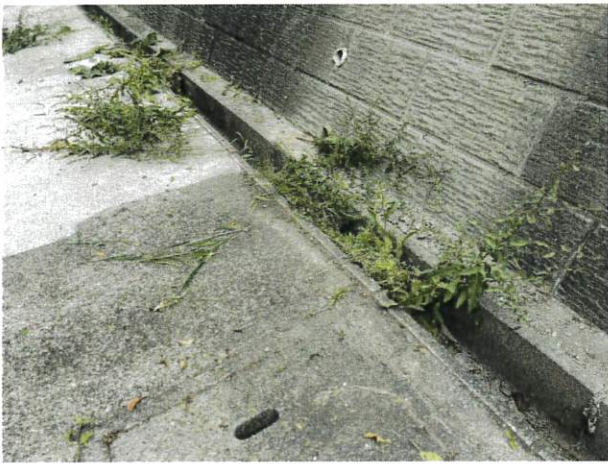
体育館横側溝
