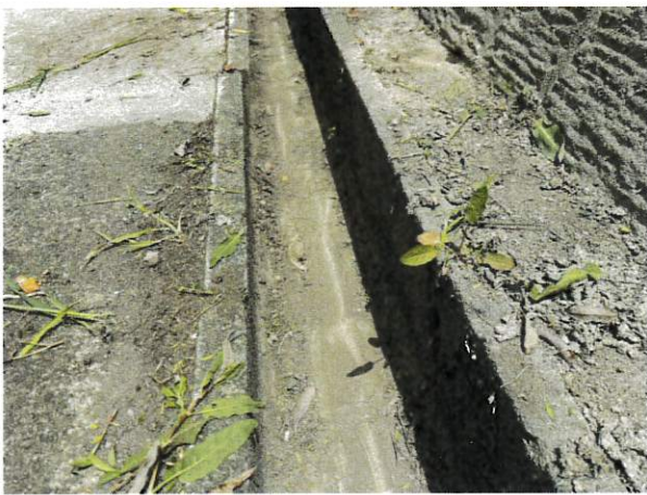
体育館横側溝
