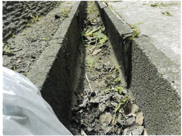
体育館横側溝
