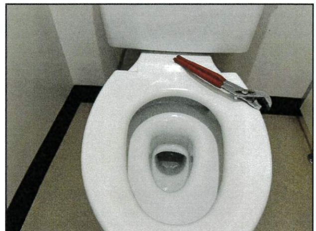
体育館女子トイレ修理
