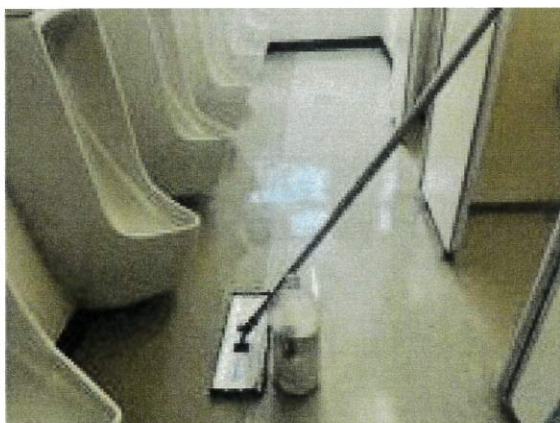
C棟トイレワックス作業
