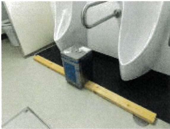
体育館トイレ床修理
