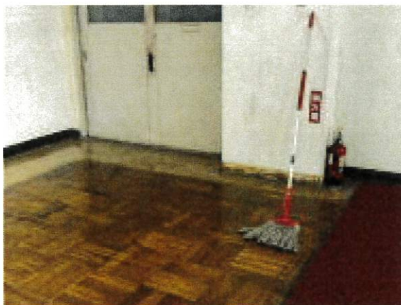
C棟昇降口ワックス作業
