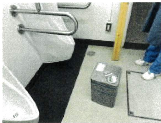
体育館トイレ補修
