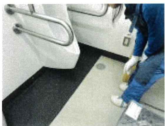
体育館トイレ補修
