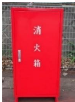
初期消火箱（固定式）
